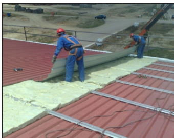
EST. Estructuras metálicas
