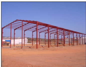
EST. Estructuras metálicas
