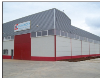
EST. Estructuras metálicas
