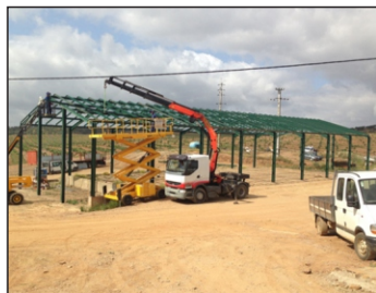
EST. Estructuras metálicas
