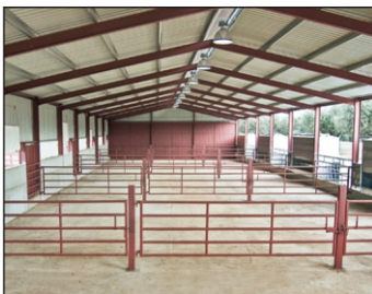
EST. Estructuras metálicas
