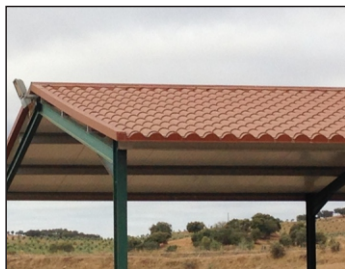
EST. Estructuras metálicas
